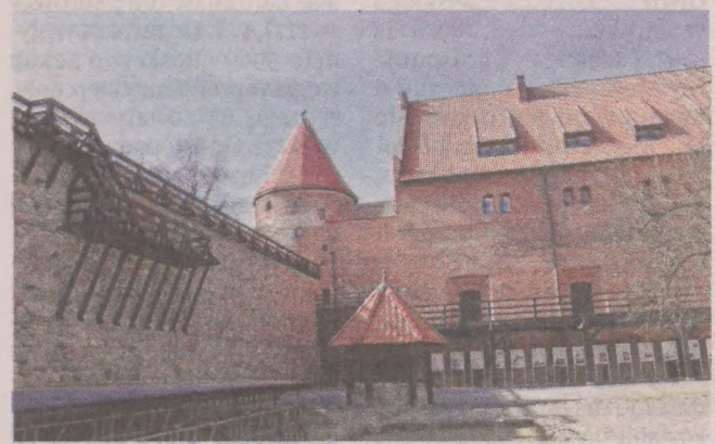
Bytowski zamek musi być dostosowany do przepisów przeciwpożarowych
