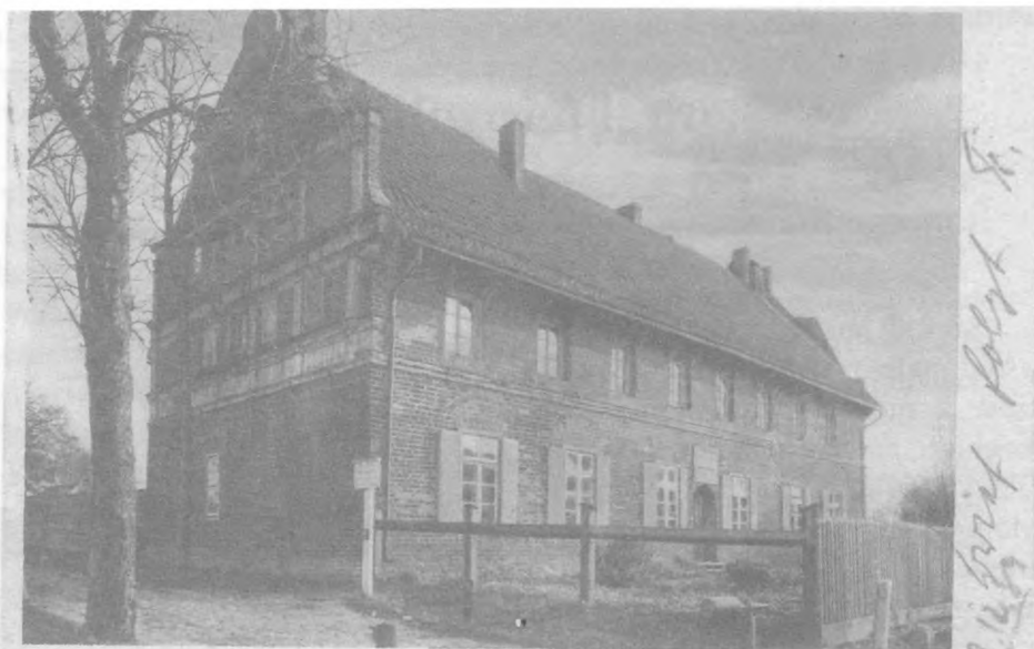
Szpital Jerozolimski po remoncie w 1907 roku – budynek pełnił wtedy pierwotną funkcję, czyli miejsca dla biednych, zmęczonych życiem osób
