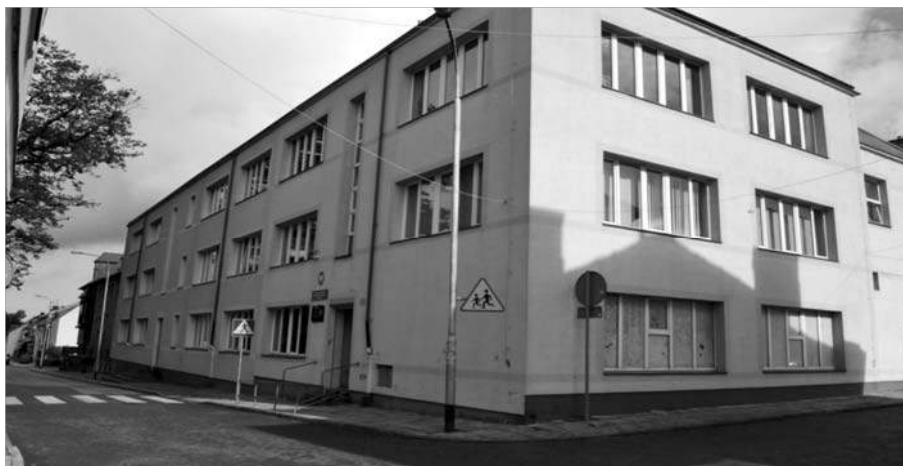
Ryc. 3. Miejskie Gimnazjum po wykonaniu nowej elewacji w 2007 r. (źródło: Kronika Miejskiego Gimnazjum, 2007/2008 )
