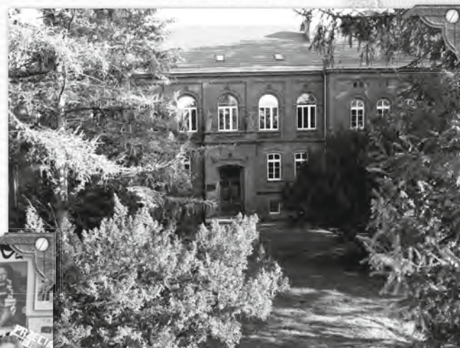
Budynek Zespołu Szkół w Sławnie im. Jana Henryka Dąbrowskiego z nowym pokryciem dachowym (elewacja północna), sierpień 2024
