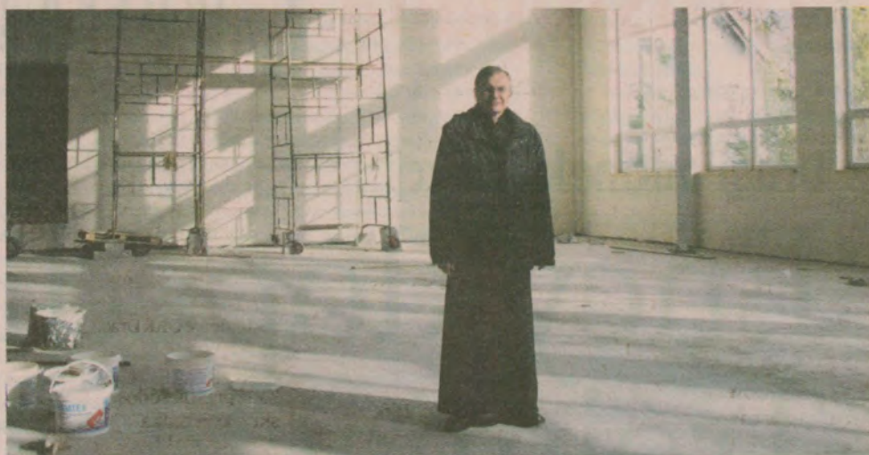
Budowa sali sportowej w Łęgowie dobiega końca. Na zdjęciu ksiądz Grzegorz Rafiński
