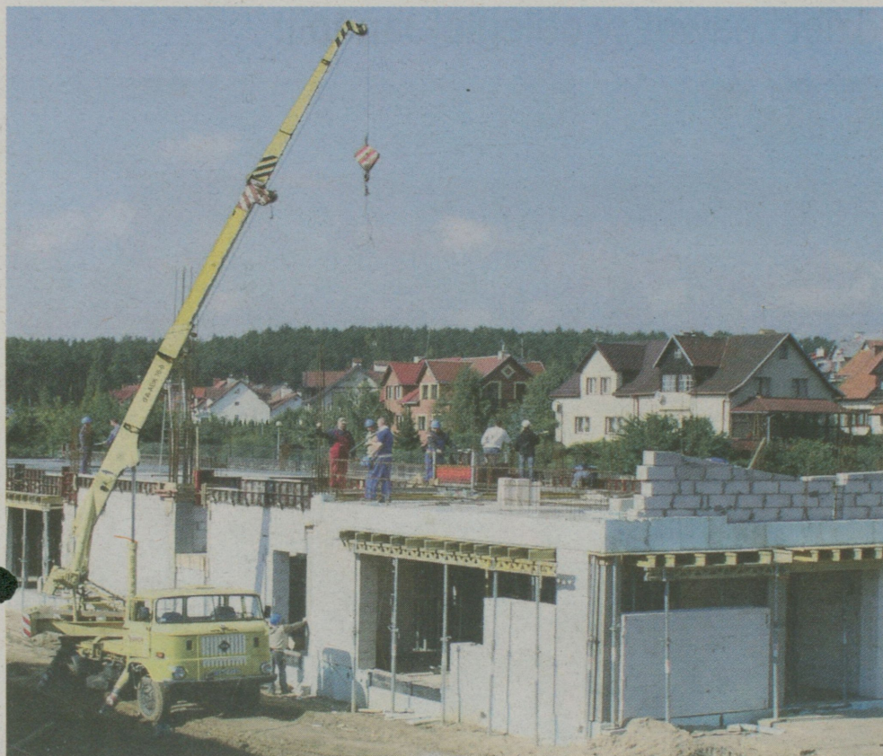
W związku z licznymi budowlami na rynku pracy powstał w tej branży deficyt kadrowy
