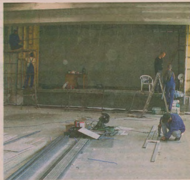
Sala widowiskowa w Kolbudach przechodzi kompleksowy remont
