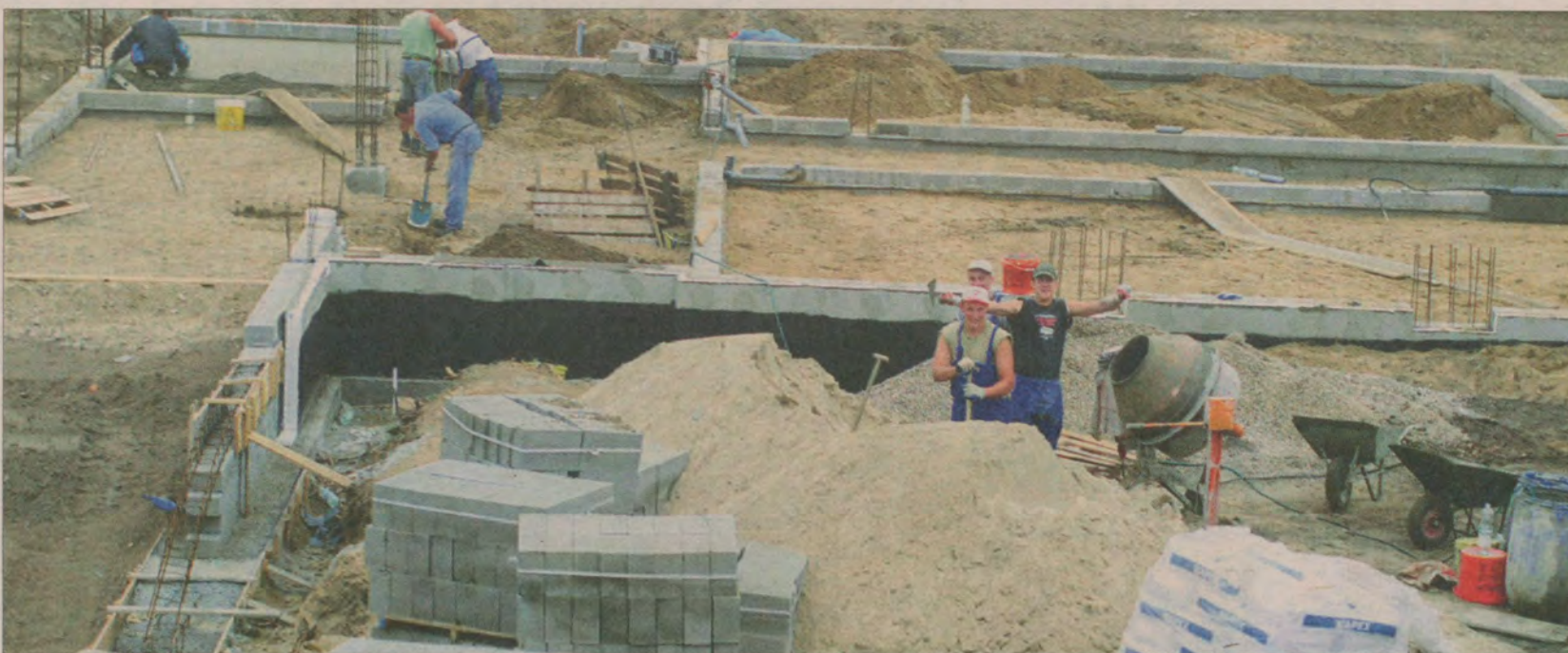
Rozpoczęła się przebudowa Zespołu Szkół w Straszynie.
