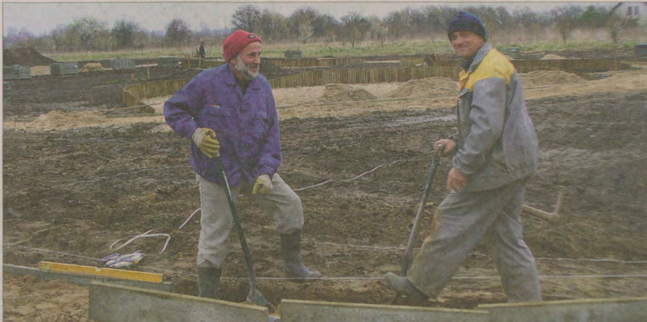
Trwa budowa parku przy ul. Świętego Wojciecha w Pruszczu Gdańskim.
