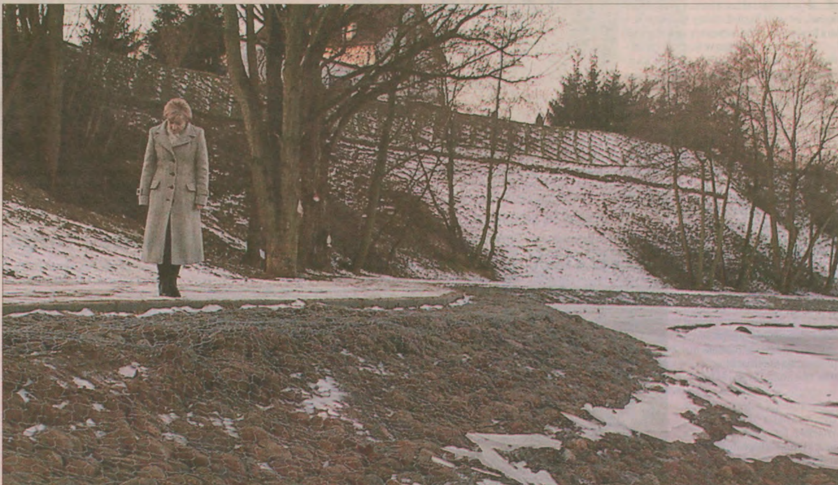
Osłabiony powodzią brzeg Raduni w Juszkowie, po 7 latach został wzmocniony.
