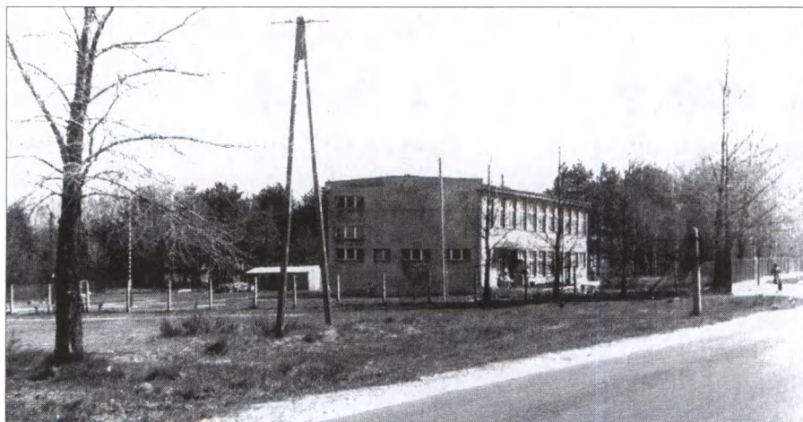
Nowy budynek szkoły „Tysiąclatki” oddany w 1964 roku. Fot. arch. SP Wrzeście.
