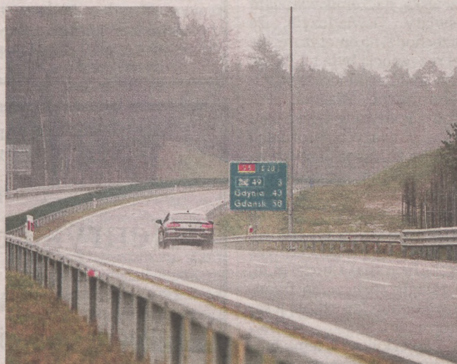
Pod koniec 2022 r. została otwarta Trasa Kaszubska (na zdjęciu), która jest częścią S6. Trwają prace przygotowawcze dla budowy S6 od Luzina do Leśnic
