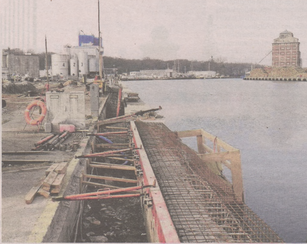
Prace nad betonowym oczępem nabrzeża
