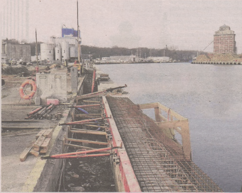
Prace nad betonowym oczępem nabrzeża
