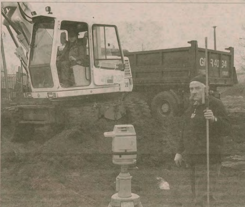
Rozpoczęły się prace przy budowie boiska na ul. Kasprowicza w Pruszczu. Marian Złoch kontroluje głębokość wykopu. W koparce operator Józef Drzonowski.
