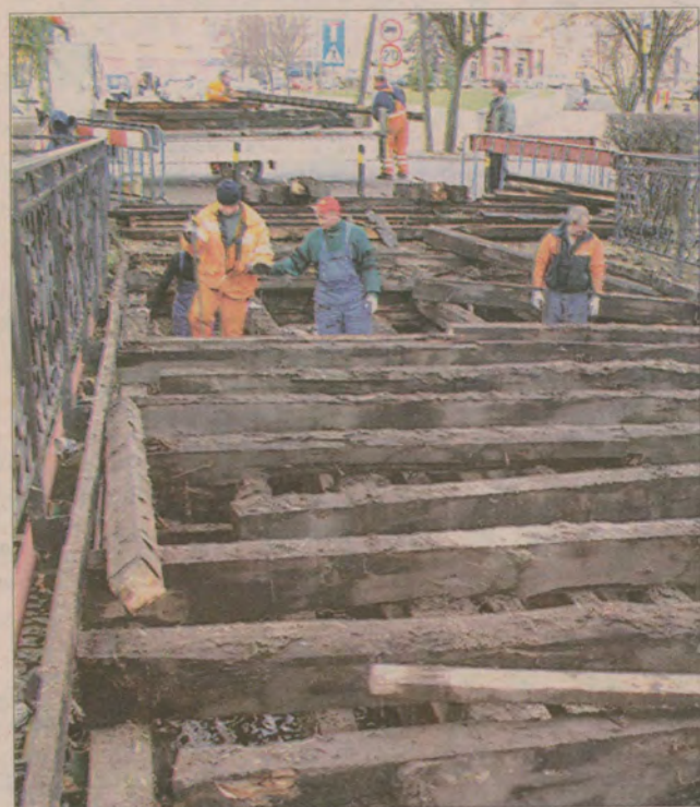
Kładka nad Kanałem Raduni została rozebrana na czas remontu.
