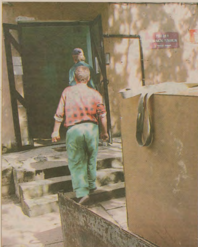
W siedzibie pruszczańskiej Temidy wykryto szkodliwy dla zdrowia ksyłomit.
