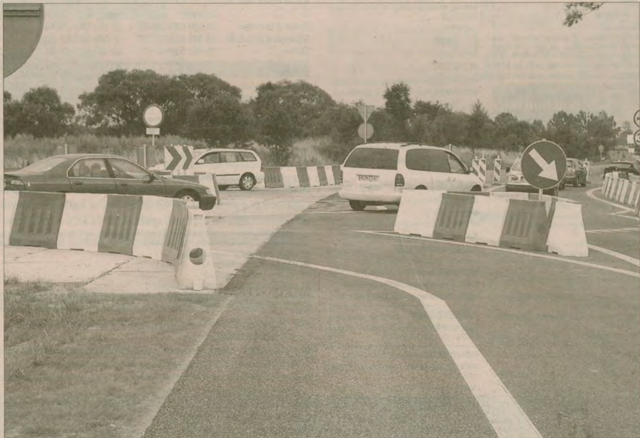
Skrzyżowanie ul. Zastawnej z obwodnicą zostało zamknięte. Jeździmy tymczasowym rondem.
