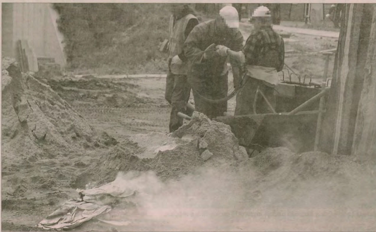
~ Ognisko na budowie w centrum Pruszcza Gdańskiego – dym zasnuł okolicę.
