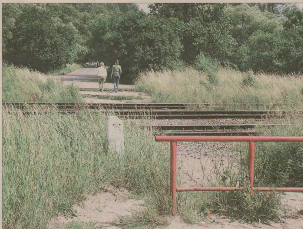
Przy dawnym przejeździe kolejowym na ul. Sikorskiego w Pruszczu Gdańskim, barierka przed torami stoi tylko po zachodniej stronie miasta.
