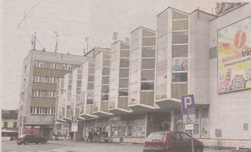
Obecny budynek dworca PKP w Słupsku zostanie rozebrany
