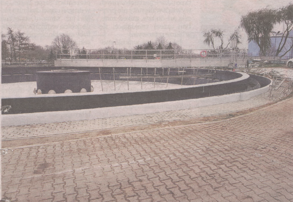
Modernizacja zbiornika retencyjno-przelewowego na OŚ w Słupsku
