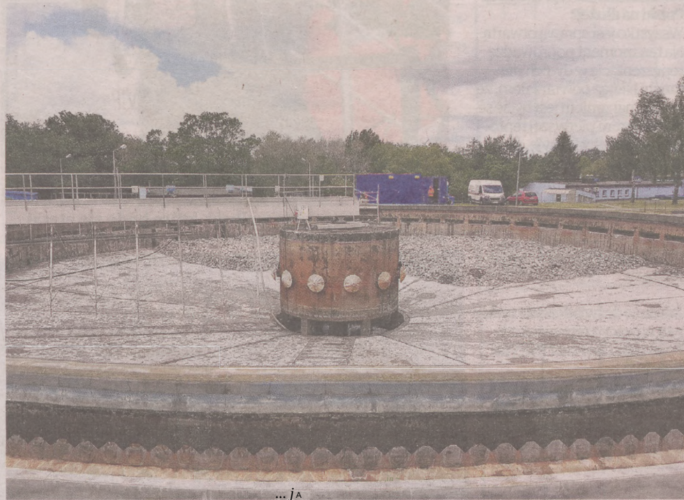
Modernizacja zbiornika retencyjno-przelewowego na OŚ w Słupsku
