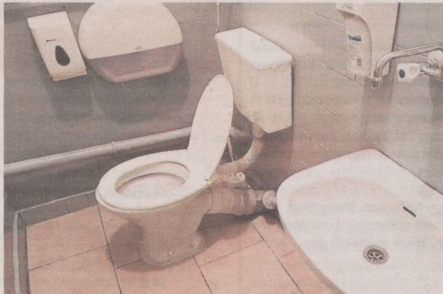
Toaleta po „remontcie”
