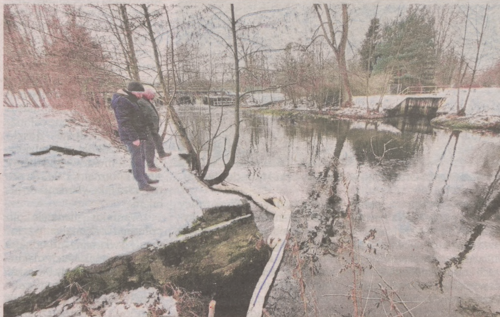
Wyciek ustał, a wylot kolektora został zabezpieczony rękawami sorpcyjnymi
