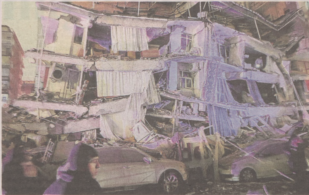
Trzęsienie ziemi zniszczyło kilka tysięcy budynków, w których przebywali ludzie
