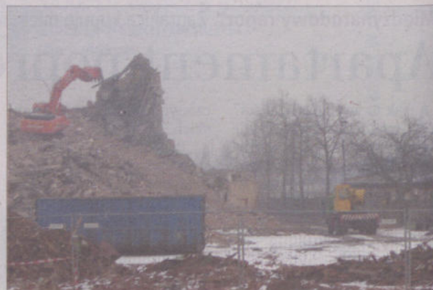
Demontaż ruin w rejonie ul. Wałowej.
