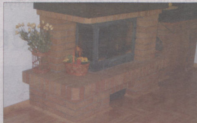
Do obudowy kominika wystarczy ok. 100 cegieł. Fot. EkoKLINKIER
