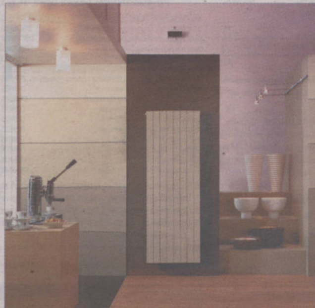
Grzejnik płytowy w otwartej przestrzeni między kuchnią a salonem.
