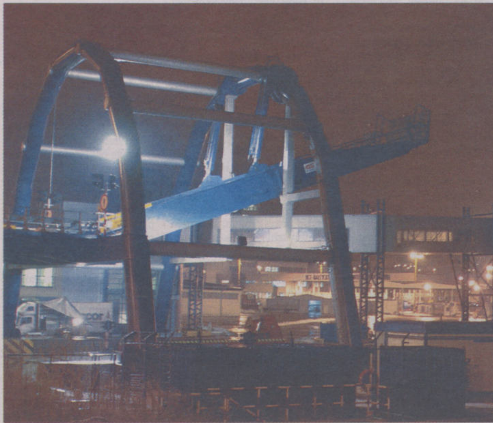
Nowoczesna rampa przeładunkowa w gdyńskim porcie.
