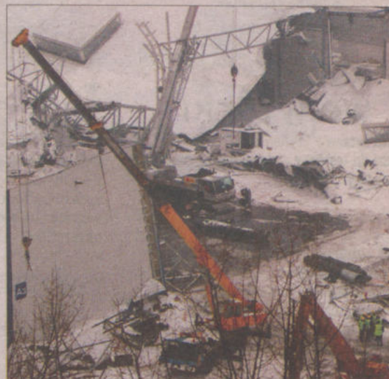
W Chorzowie trwa rozbiórka hali i z gruzowiska ciągle są wydobywane rzeczy osobiste ofiar katastrofy.
