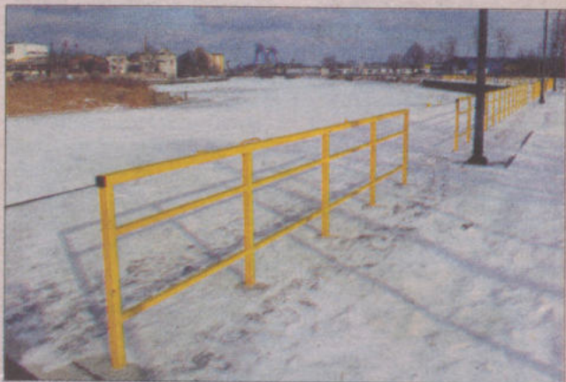
Zakończono odbudowę odcinka nabrzeża w starym, historycznym porcie gdańskim nad Motławą, znajdującego się u wylotu Kanału na Stępcie.
