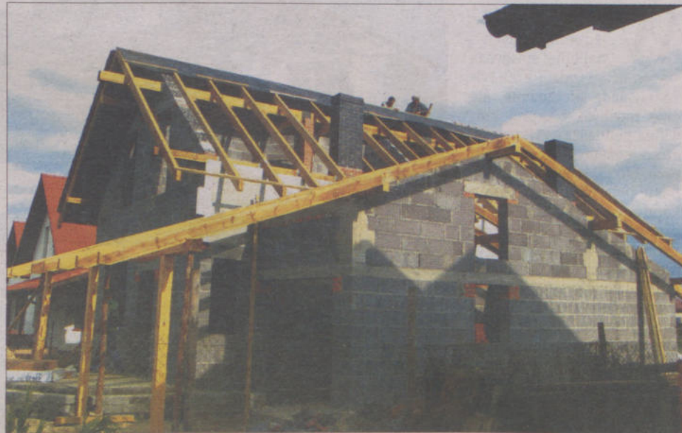
Więźba dachowa jest obliczana w stosunku do rodzaju materiału jakim pokryjemy dach.
