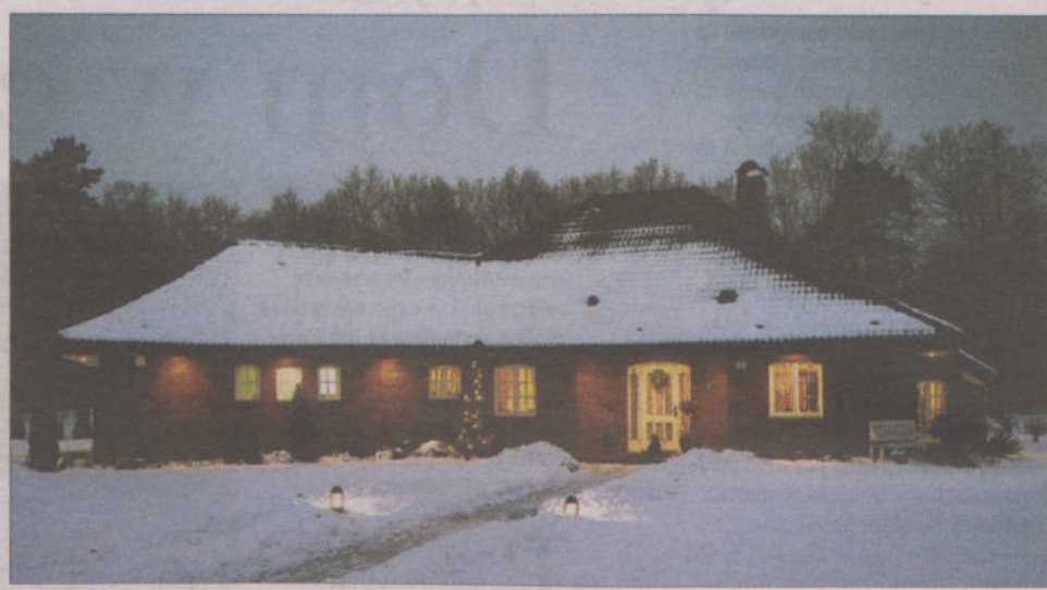
Największym problemem jest zadaszenie parterowych budynków typu bungalów, o dużej powierzchni.
