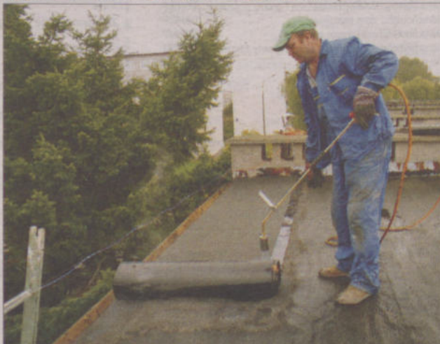
Papy termozgrzewalne to nowa jakość krycia.
