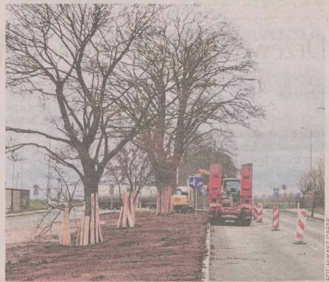
Prace na ul. Grunwaldzkiej. Rosnące tam drzewa zostały zabezpieczone przed uszkodzeniem
