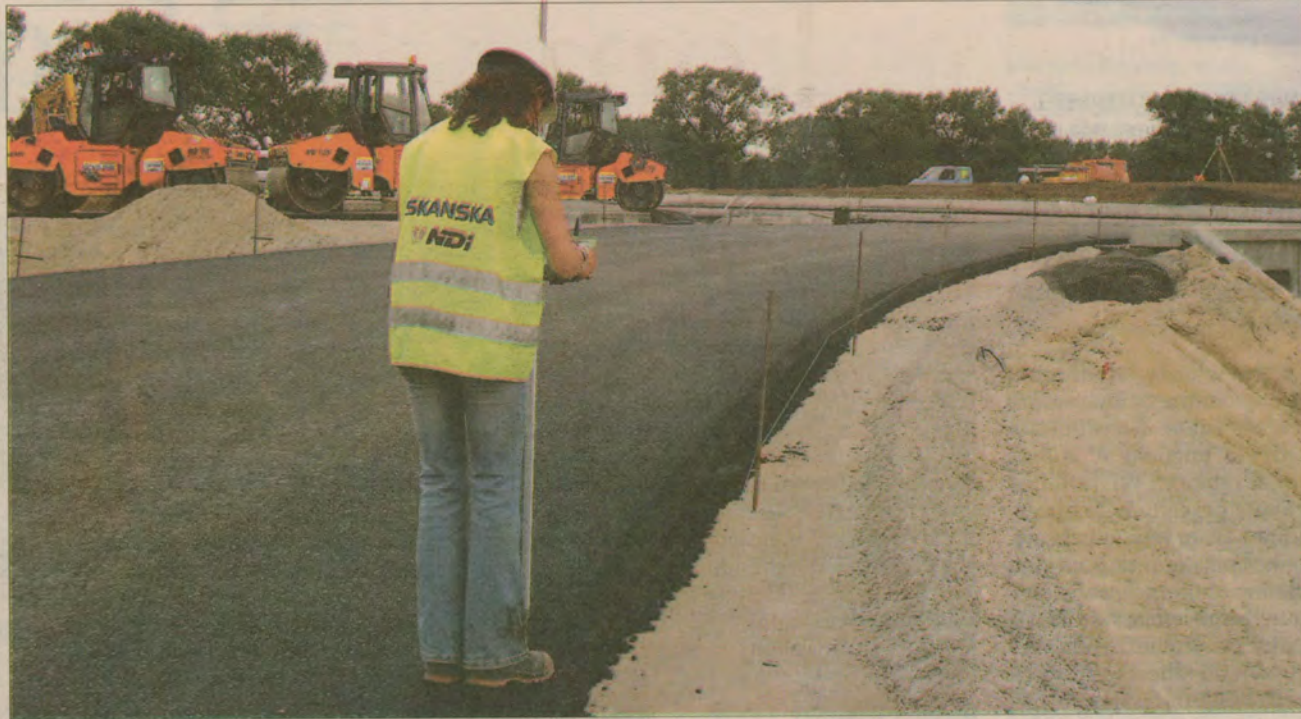
Na budowie autostrady A-1 trwają prace wykończeniowe.
