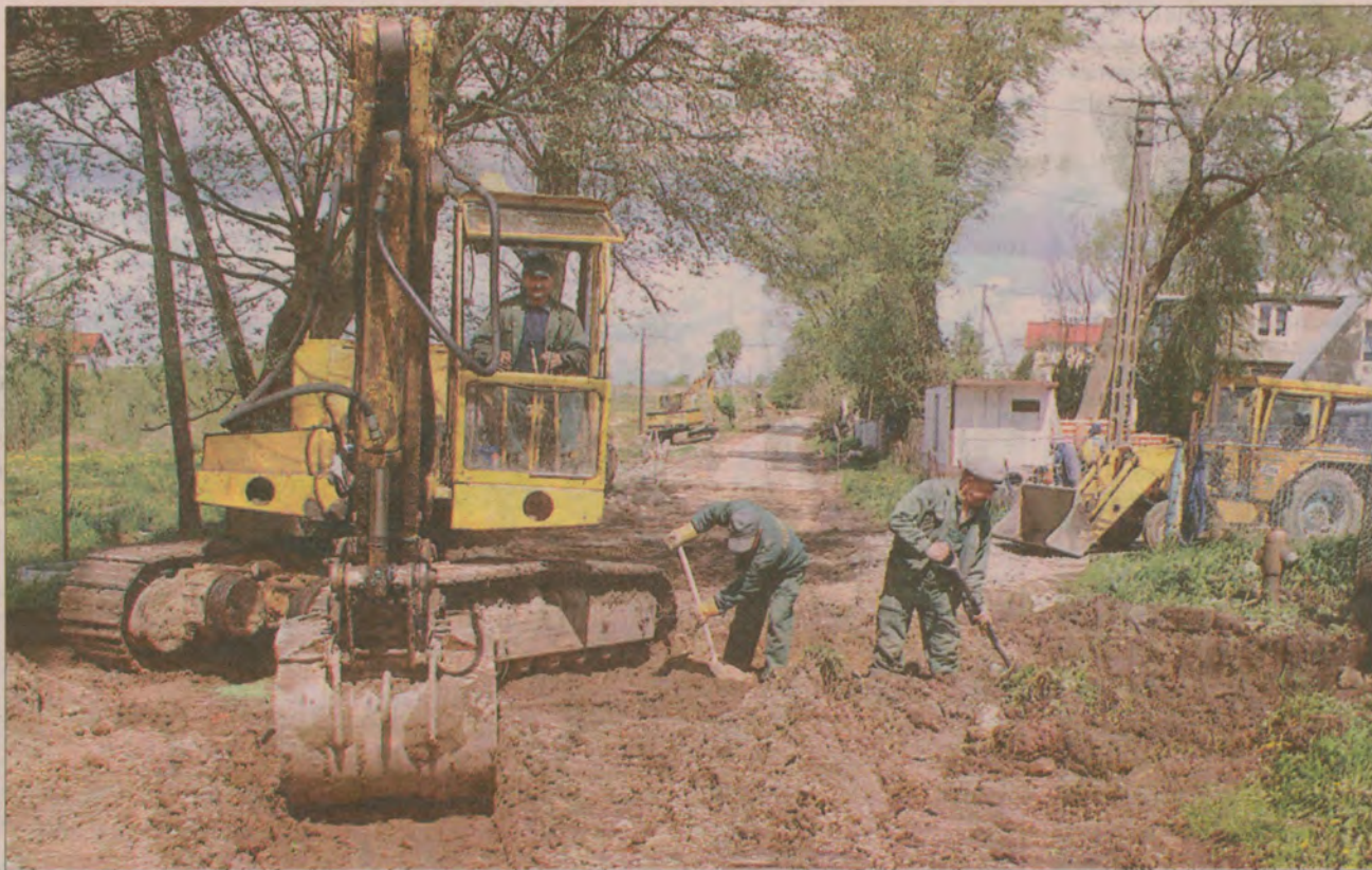
Trwa budowa kanalizacji na ul. Straszynskiej w Jankowie.
