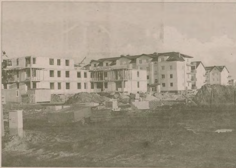
Tak plac budowy wyglądał jeszcze w piątek, dziś jest już ogrodzony białą-czerwoną taśmą.
