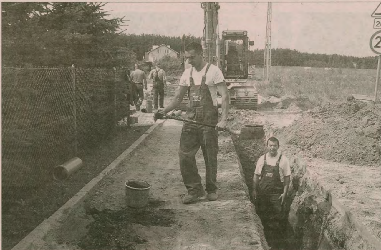
W tym roku takich obrazków nie zobaczymy - na zdjęciu budowa kanalizacji w Juszkowie w gminie Pruszcz Gd.
