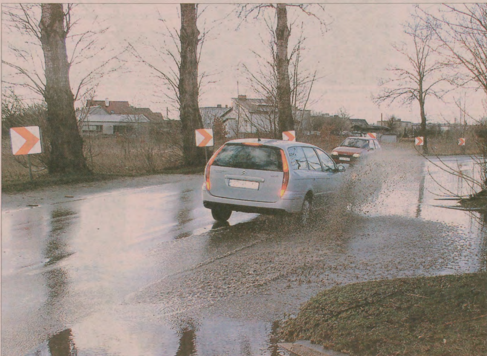
Na samochody wjeżdżające do Pruszcza ulicą Kopernika czeka ogromna kałuża.
