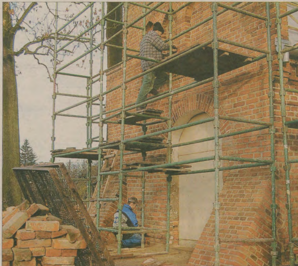
Remont kościoła parafialnego w Krzywym Kole.
