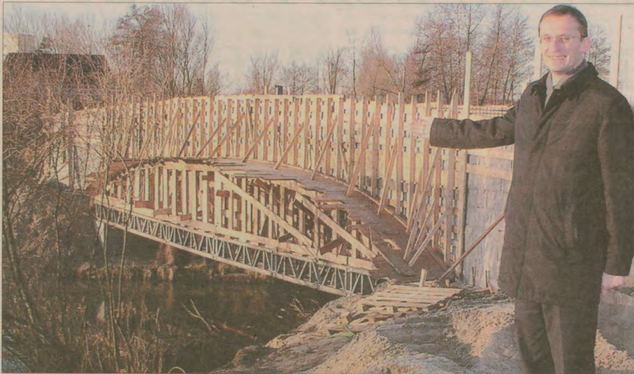
Janusz Wróbel na placu budowy Faktorii Rzymskiej.
