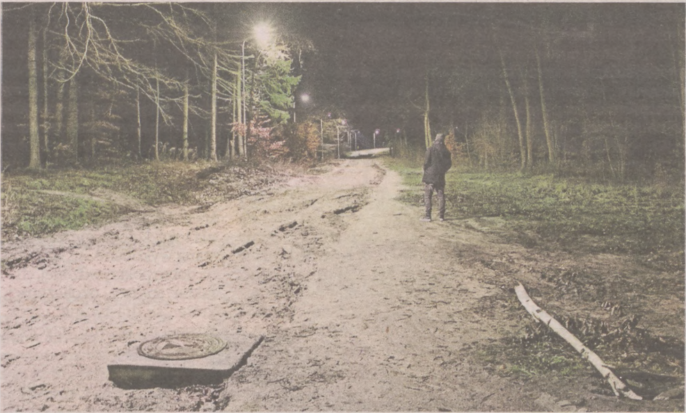
Choć droga nie ma już utwardzonej nawierzchni, to nadal jeżdżą po niej samochody. Natomiast sześciu lamp nie da się wyłączyć
