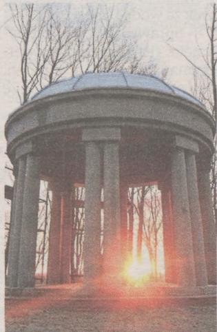
Panteon w Biesowicach po renowacji. Obiekt wybudowany w 1924 roku stoi w lesie
