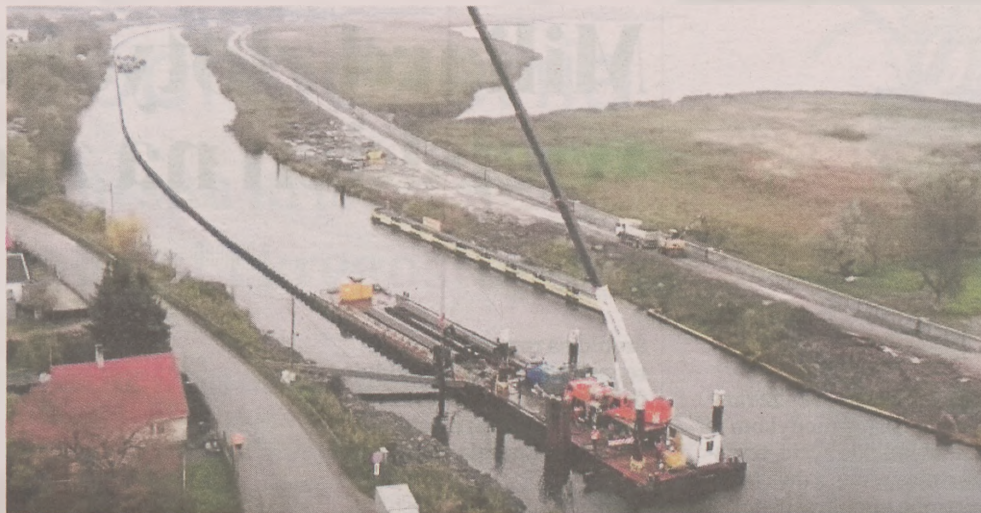
Zakończona we wrześniu 2022 r. część budowy 23 drogi wodnej, łączącej Zalew Wiślany z Zatoką Gdańską, to tylko część całej inwestycji
