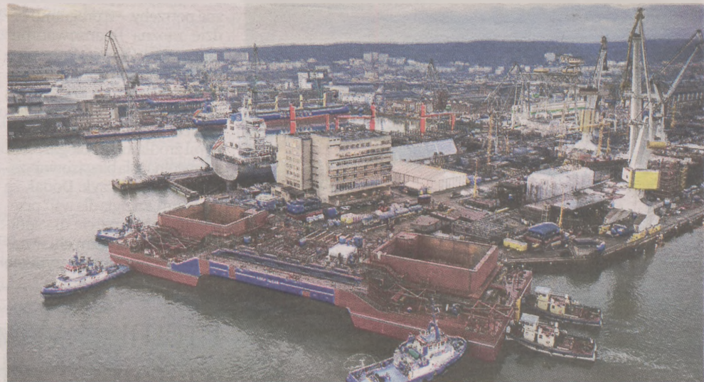
Zrealizowana została budowa specjalnej jednostki do budowy tunelu Dania-Niemcy
