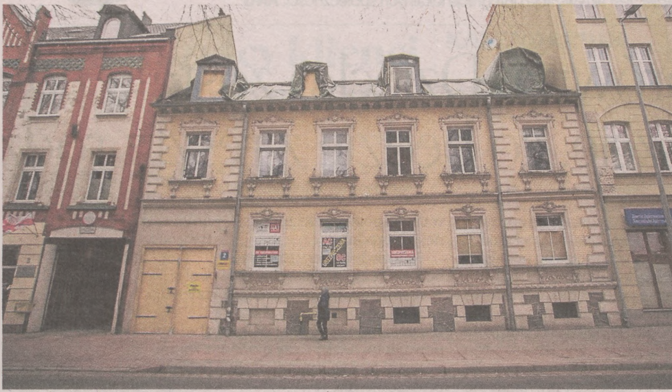
Kamienica przy ul. Tuwima 2 pochodzi z połowy XIX wieku. Jest wpisana do rejestru zabytków
