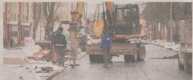
Kucie dziur w asfalcie na remontowanej ulicy Wiejskiej. Realizacja inwestycji ma zakończyć się w maju
