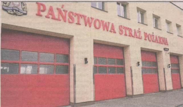
Budynek główny Jednostki Ratowniczo-Gaśniczej Państwowej Straży Pożarnej w Miastku
