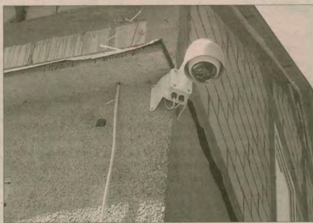
Kamera na budynku Urzędu Gminy w Kolbudach.
