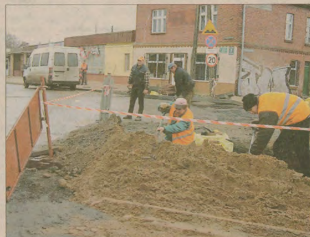
Ostatnie prace na remontowanej ul. Powstańców Warszawy w Pruszczu.
