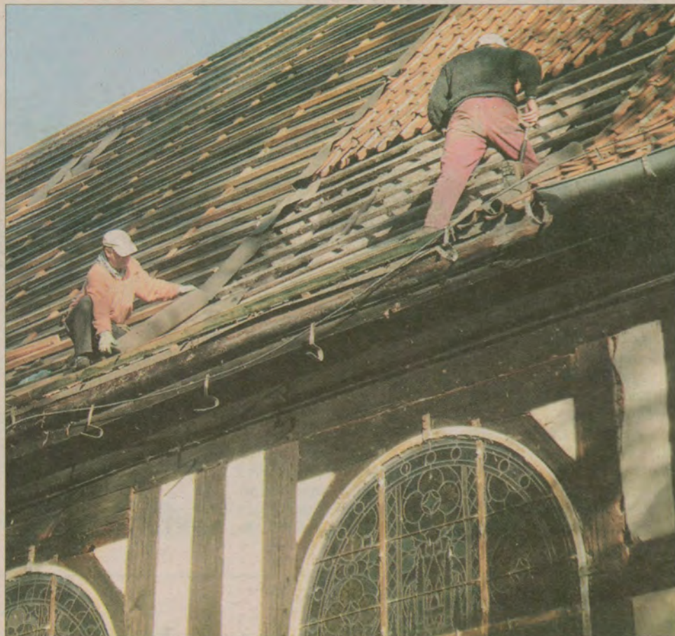
Bogdan Wolski i Jerzy Pawelec remontują dach kościoła w Kiezmarku.
