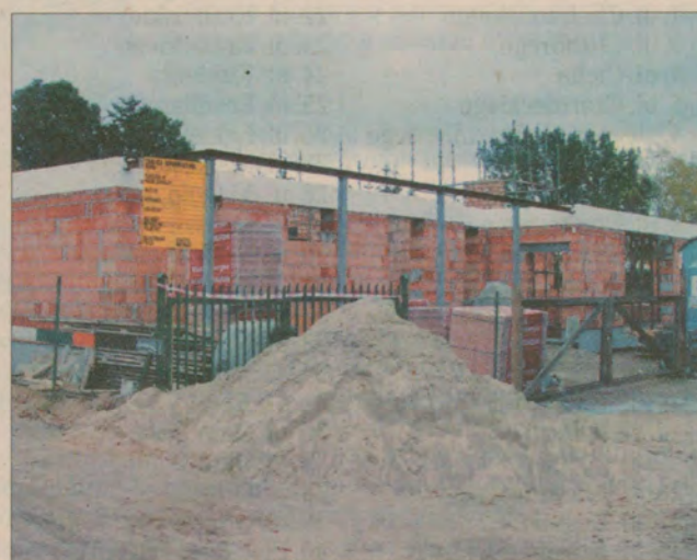
Budowa świetlicy wiejskiej w Kowalach.
