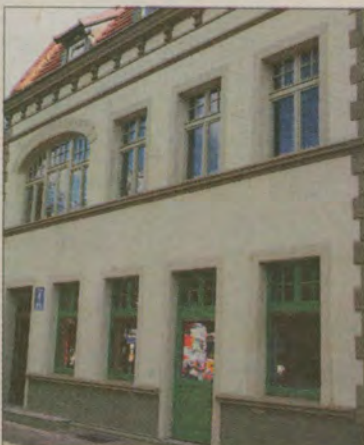
Nowa elewacja budynku przy ul. Krótkiej
