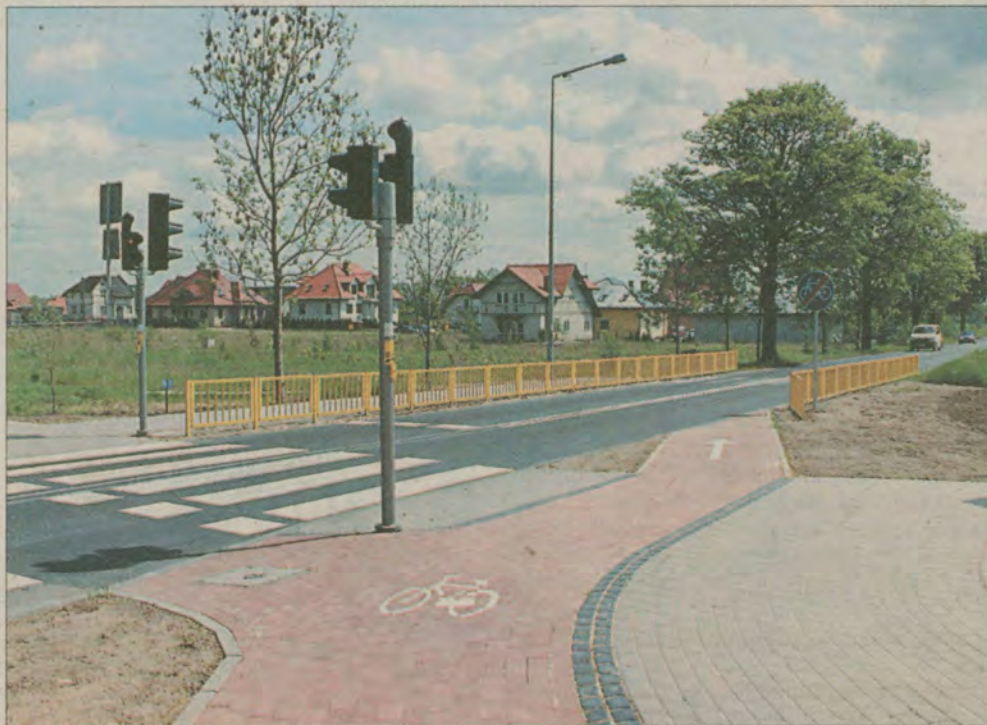
Remont drogi i sygnalizacji Rotmanka.
