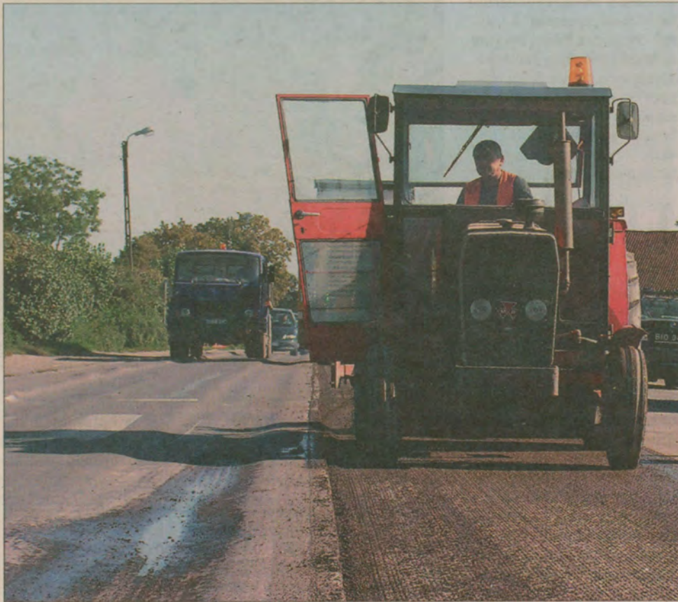
W ubiegły weekend, drogę krajową nr 1 opanowały frezarki.
