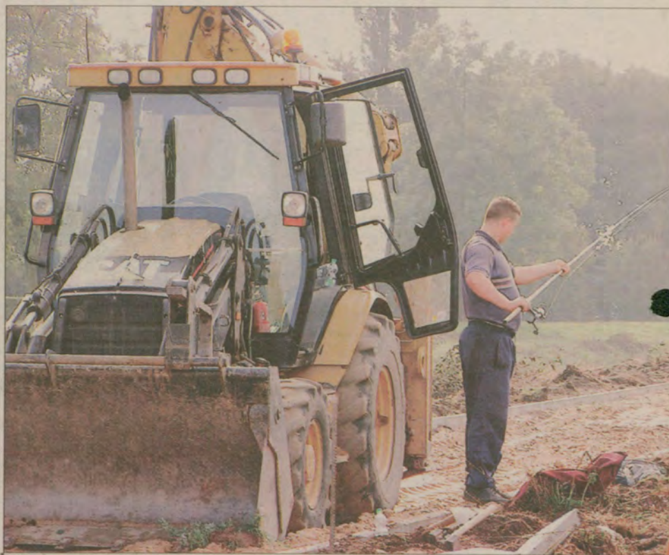
Jak widać, trwają intensywne prace przy budowie Bursztynowego Szlaku.
