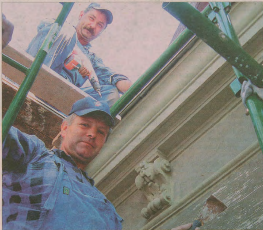
Marek Chołuj i Krzysztof Fryca (na górze) odnawiają budynek przy ul. Krótkiej 4.
