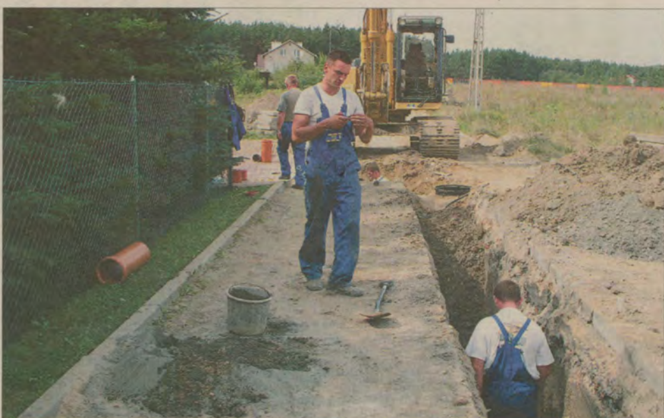
Mieszkańcy Juszkowa długo czekali na kanalizację. Ostatni odcinek rury położono pod ulicą Ogrodową.
