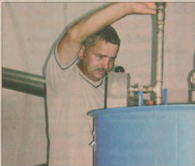
Sylwester Bogun, pracownik oczyszczalni, obsługuje specjalistyczne urządzenie do rozrabiania polimerów.
