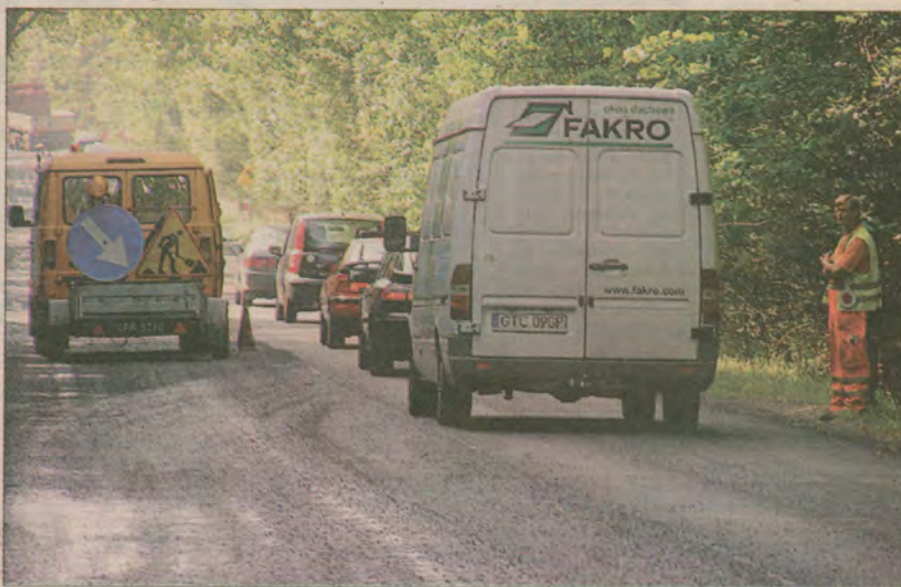
Trwa remont drogi nr 222.
