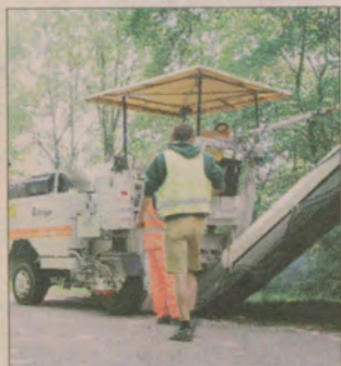
Drogowcy rozpoczęli remont trasy nr 233 z Mierzeszyna do Trzepowa.
