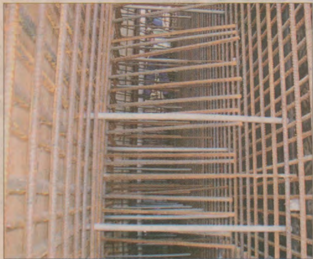
Trwają prace przy budowie mostu w Ulkowach.
