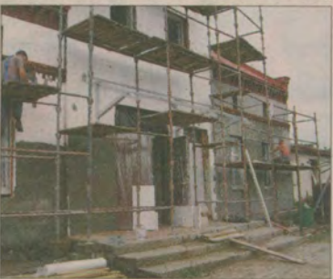
Trwa remont świetlicy wiejskiej w Skowarczu. W budynku powstanie Muzeum Miodu.
